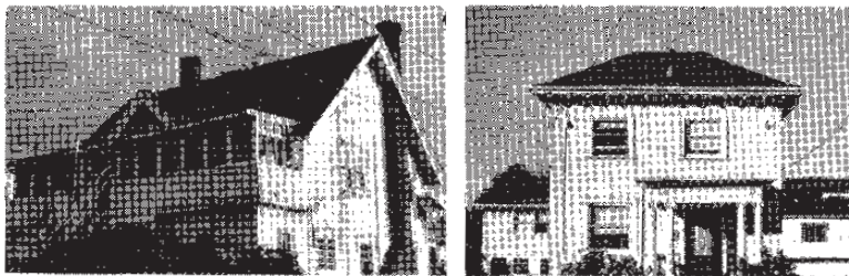
Im einen Dach wird gelebt, das andere ist aufgesetzt.
